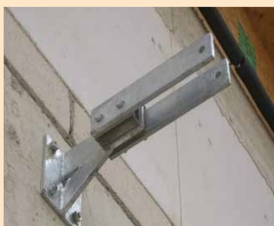
Entwicklung von Wärmebrücken-freien Montagekonsolen
