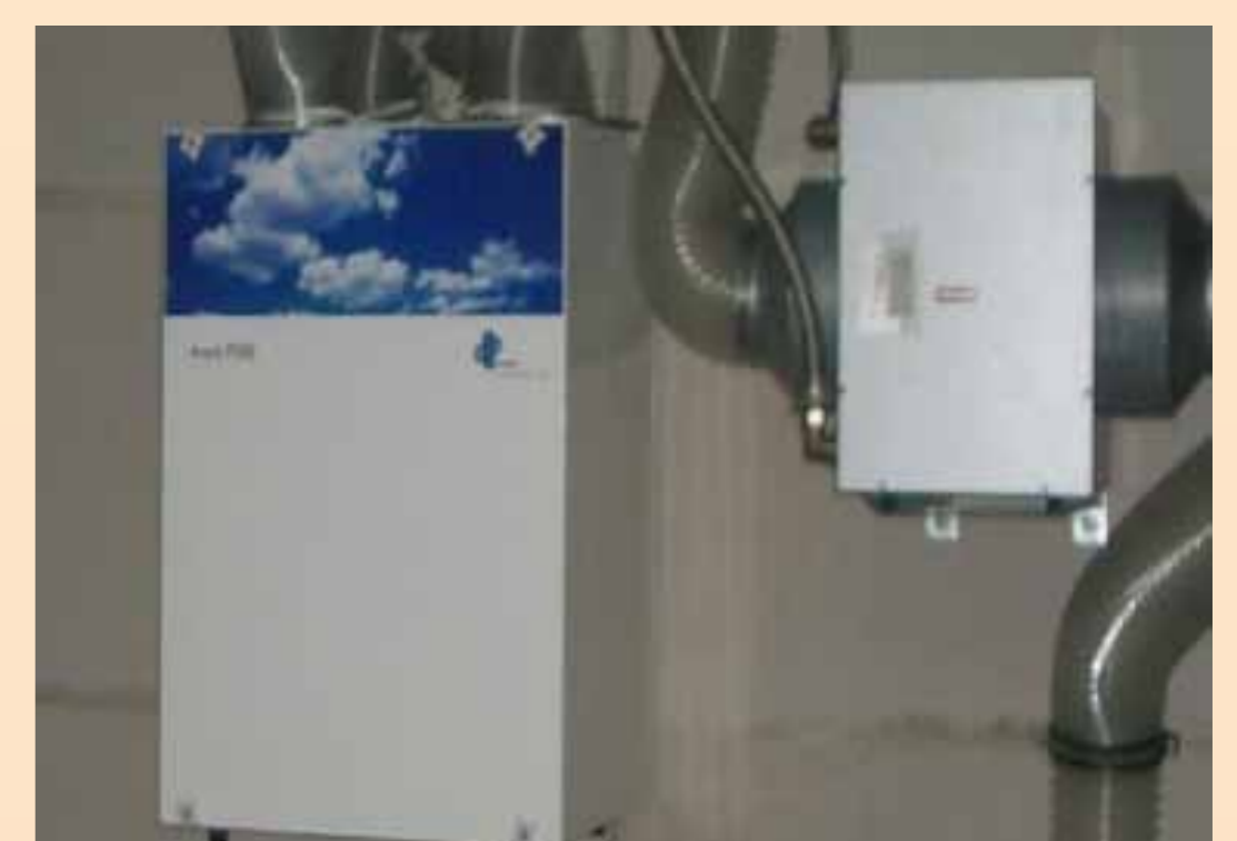
So klein ist die Passivhaustechnik : kompakte Lüftungsanlage mit ca. 90% Wärmerückgewinnung
